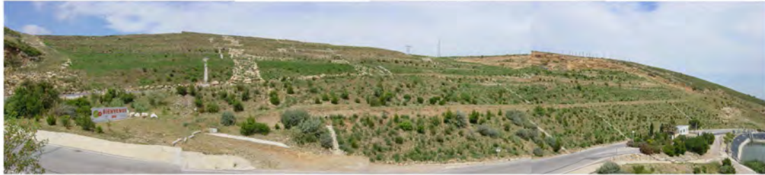
VUE 2 depuis l'intérieur du site, en juin 2010
